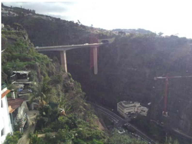
Figura 14.10 - Registro de um viaduto com via rápida da Ilha (Arquivo Pessoal)
