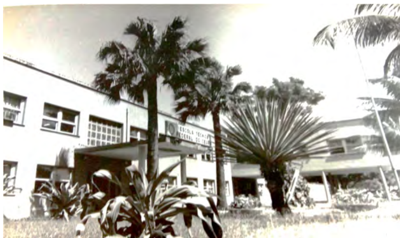
Figura 8 – Fachada da Escola Técnica Federal do Ceará
