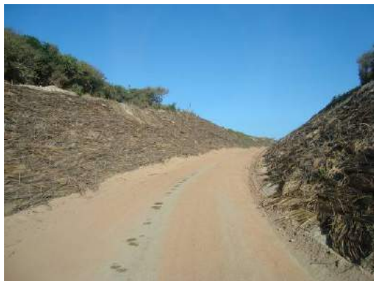
Figura 15 - utilização de palhas de coqueiro para fixação das areias que se direcionam para a estrada (campo de dunas Cumbe/Canoa Quebrada). (Foto: J. Meireles, outubro de 2009).
