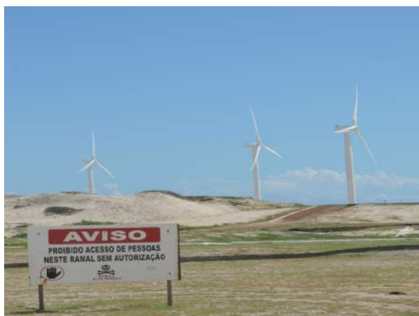
Figura 4 – Placa indicando acesso apenas de pessoas autorizadas. Fonte: Meireles, 2014
