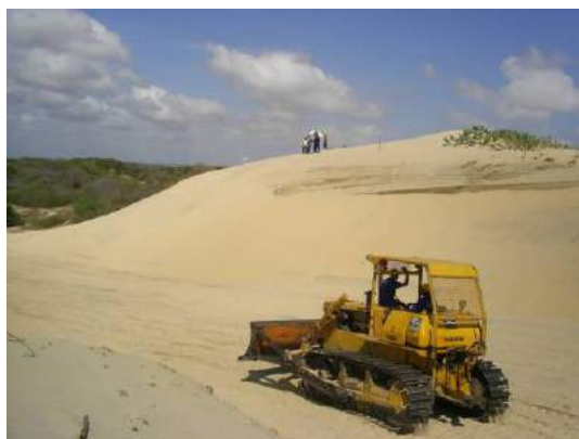
Figura 9 – Corte realizado em uma duna móvel. Verificar que a duna foi seccionada para a implantação de uma via de acesso (campo de dunas da Taíba). (Foto: J. Meireles, abril de 2008).
