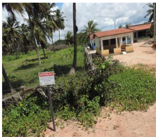
Figura 3 – Placa indicando risco de morte, próximo a residência, em Amontada/CE Fonte: arquivo pessoal, 2014
