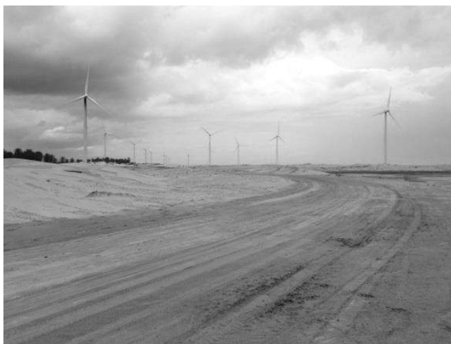
Figura 1 – Compactação do campo de dunas. Eólica Morgado
