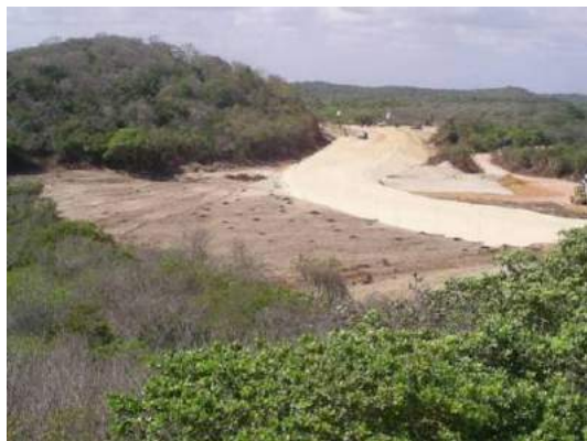
Figura 3 – Vista panorâmica do desmatamento de duna fixa. Base da duna fixa retira, com a remoção do solo para a instalação de vias de acesso de canteiro de obras (campo de dunas da Taíba). (Foto: J. Meireles, abril de 2008).
