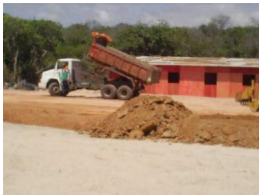
Figura 13 – material areno-argiloso introduzido no campo de dunas e sobre a via de acesso aberta para o tráfego de veículos. (campo de dunas da Taíba). (Foto: J. Meireles, abril de 2008).
