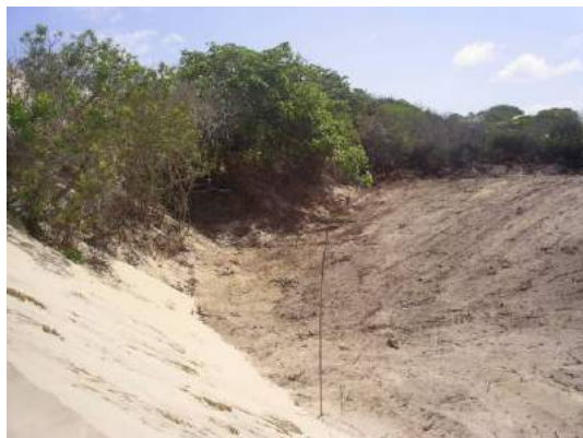
Figura 5 – Contato entre duna fixa desmatada (lado direito da fotografia) e aterro sobre área anteriormente vegetada para a abertura de vias de acesso sobre o campo de dunas fixas (campo de dunas da Taíba). (Foto: J. Meireles, abril de 2008).
